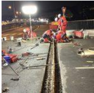
Travaux de remplacement des joints de dilatation
