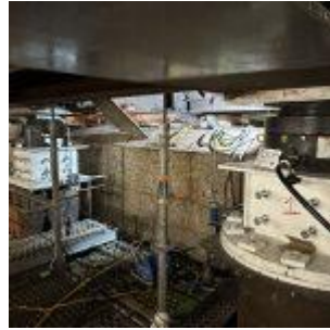
Installation des vérins pouvant supporter 600 t
